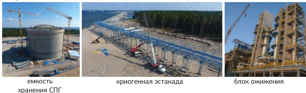
Рисунок 26: Фотографии площадки строительства КС Портовая
